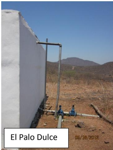
Con el programa de devolución de derechos (PRODDER), se construyó la línea de conducción del pozo profundo al tinaco de la comunidad de El Palo Dulce con un monto de \$ 220,000.00 (Doscientos veinte mil pesos 00/100 M.N.).
